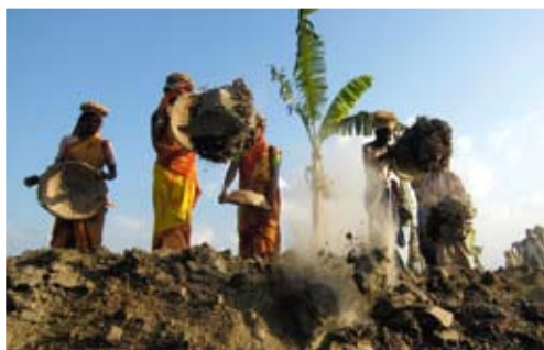
Die Arbeiter-Familien aus dem Film „Eisenfresser“ schütten in ihrem Heimatdorf ein Flutschutz-Areal auf, um gegen Überschwemmungen gewappnet zu sein.
